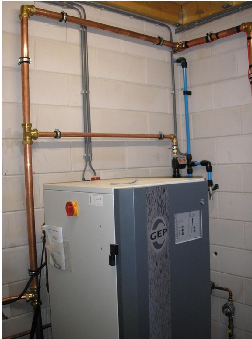
IRM-Watermanager met Trident 6.000 Regenwaterfilter
