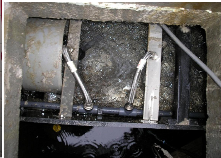
IRM-Watermanager met Trident 6.000 Regenwaterfilter
